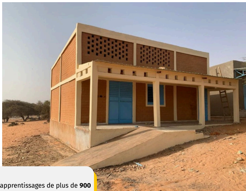
Construction de salles en BTC*
