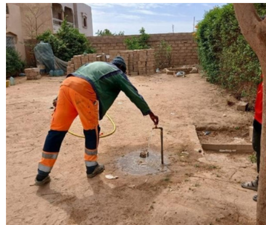
Réalisation des extensions d'eau des quartiers à Ourosogui
