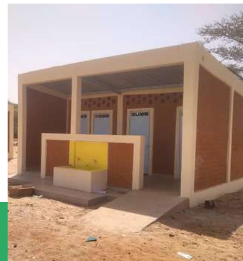
Construction des blocs sanitaires à Keur Mbaye Peulh
