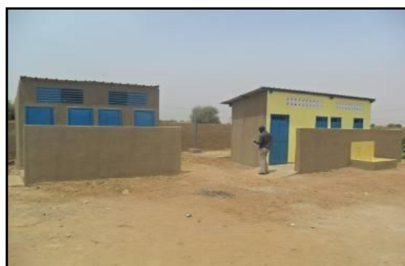
Latrines standard du programme
