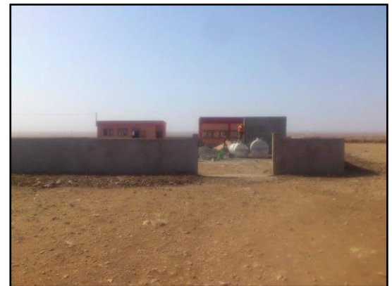
Mur de Clôture
