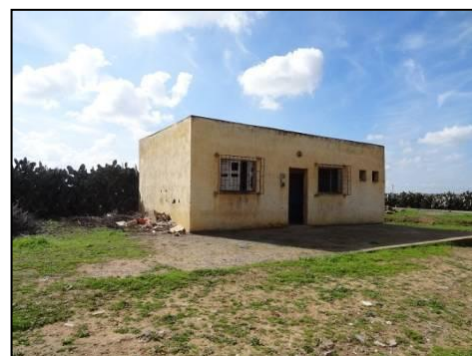
Projet de réhabilitation d'un poste de santé
