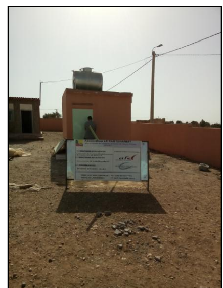
Latrines standard du programme
