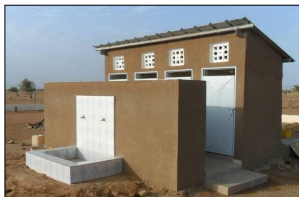
Latrines standard du programme
