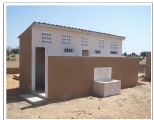
Bloc sanitaire – Collège de Saré Lamou
