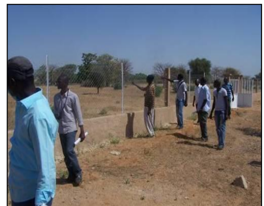
Clôture – Collège de Saré Lamou
