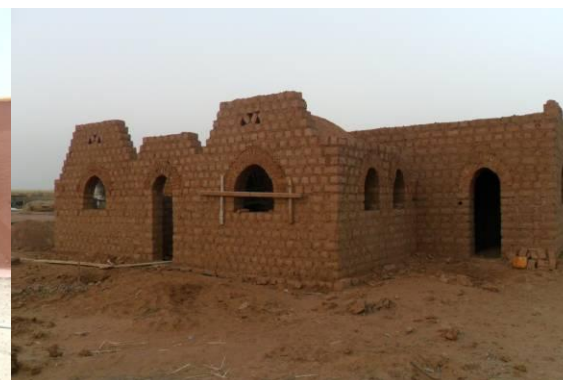
Ferme pilote en construction
