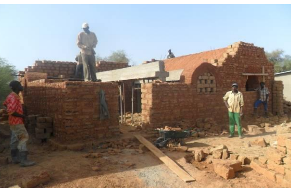
1 er Salle de Classe en VN du Sénégal (Système poutre béton)
