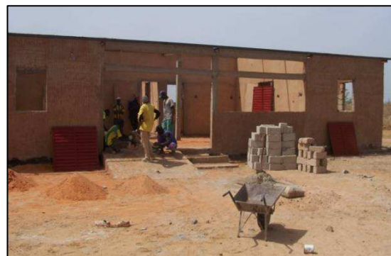
La maternité en construction
