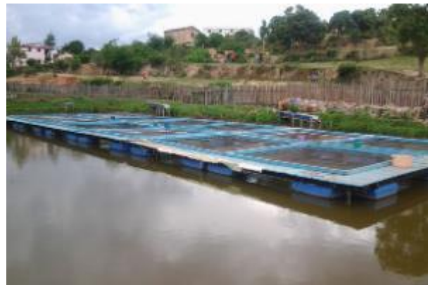
Illustration 2 : Pompe solaire de surface de 21kWc (Source : APB Energy)
