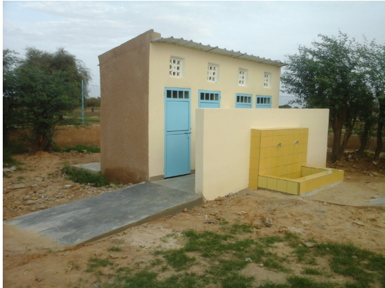
Bloc sanitaire construit
