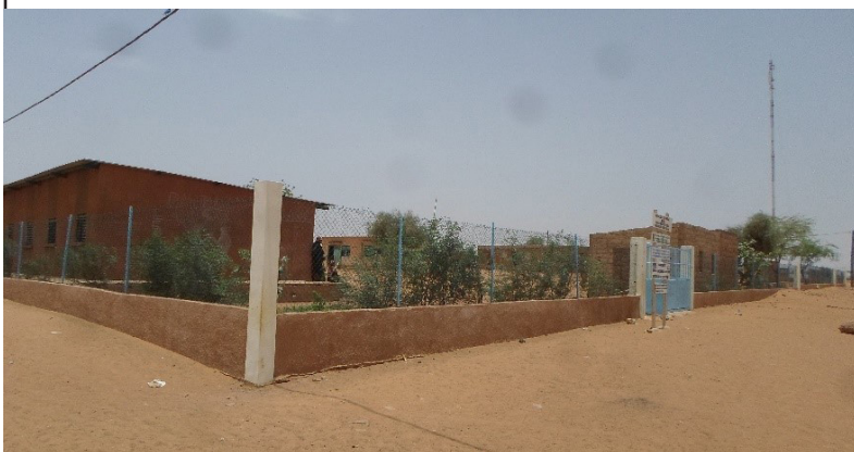
Clôture avec grillage de 1.50ml de hauteur
