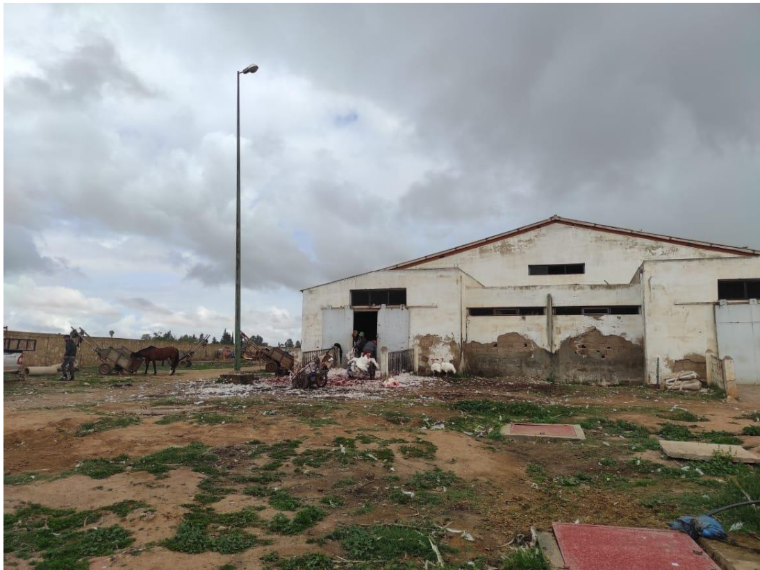
Photo de l'abattoir avec le système biogaz souterrain
