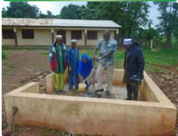
Remise point d'eau de Diountou 1 - 14/07/2022
