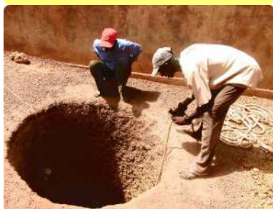
Fonçage du puits à Dombi - 15/03/22
