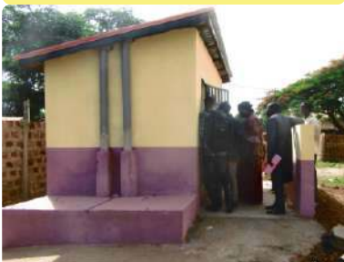
Réception provisoire des latrines de Thiaghe - 10/06/21
