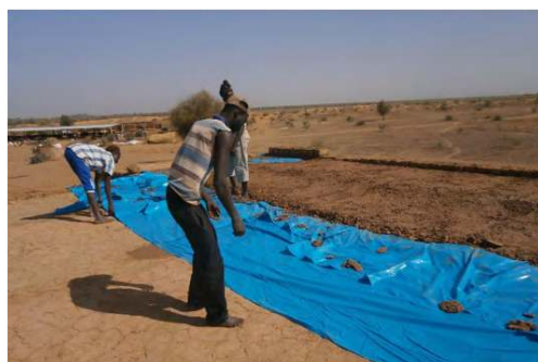
Pose de la bâche garantie d'étanchéité
