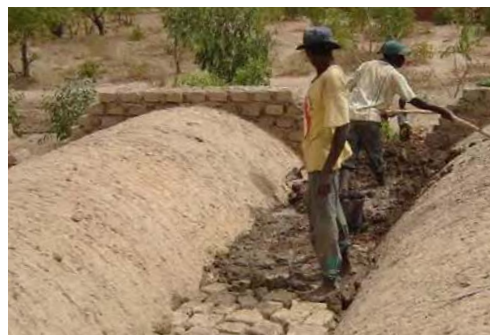
Mise en charge des contreforts
