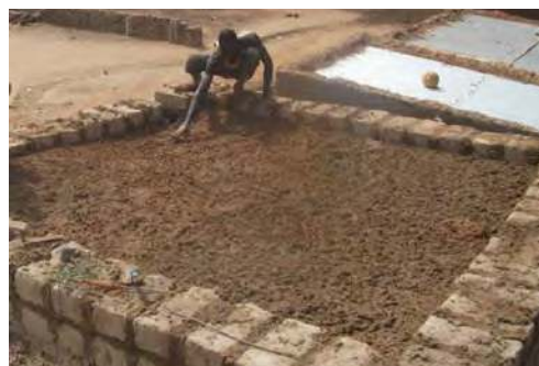
Couche de terre d'étanchéité
