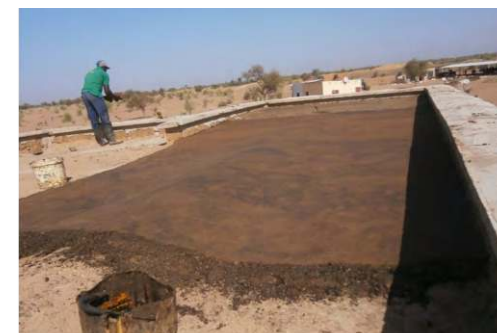
Revêtement bitume anti-érosif
