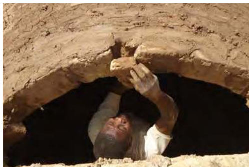
Fermeture de la voûte
