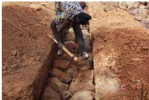
Fondation béton de terre cyclopéen
