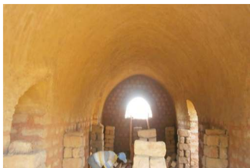
Finition : enduit mortier de terre
