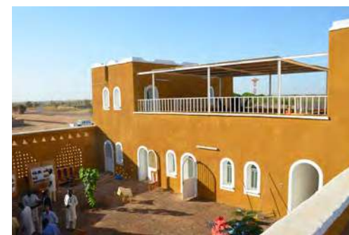
Finition : enduit ciment
