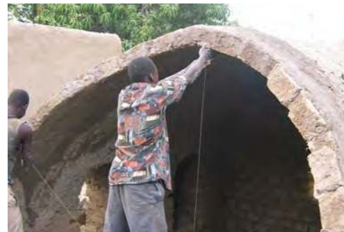
Démarrage de la voûte
