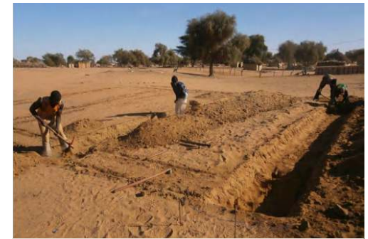
Réalisation des fouilles
