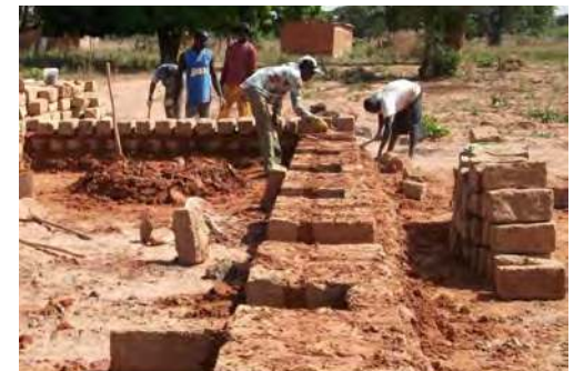
Élévation des murs porteurs
