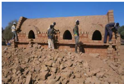
Contreforts murs porteurs
