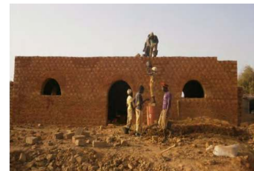
Finition des contreforts
