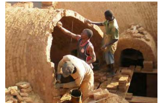
Avancée de la voûte
