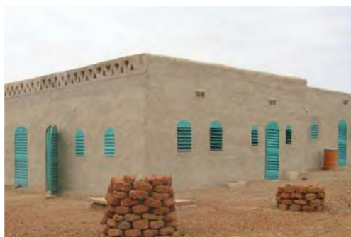
Finition : enduit terre
