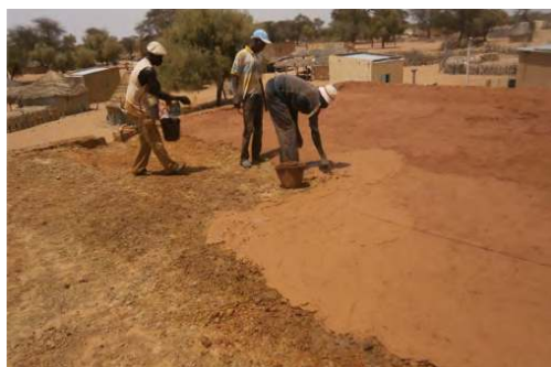
Réalisation de la pente de la toiture
