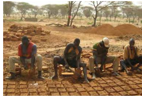
Nettoyage des briques
