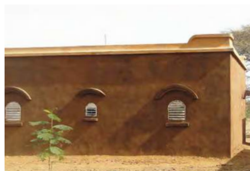
Finition : enduit terre/sable/goudron
