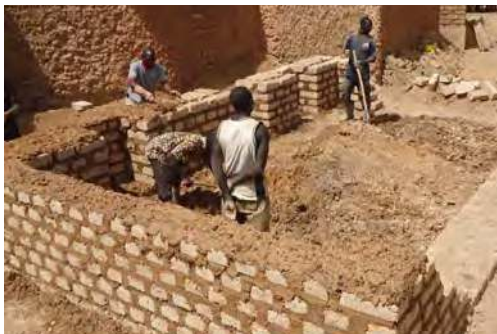
Élévation des murs pignons
