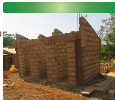
Les travaux avancent bien à Sentou - 26/03/21 (Crédit photo: IC)
