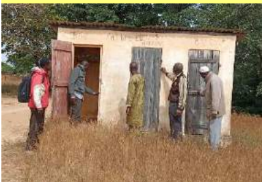
Visite des latrines de l'école de Popodara-centre - 19/11/20
