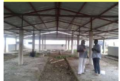
Avancement des travaux du marché Radar - 08/09/20
