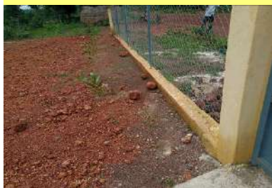
Clôture grillagée à Donghol Fafabhe - 15/07/20
