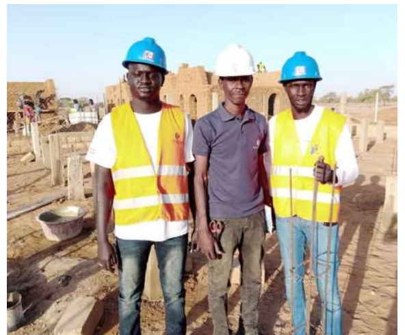
Formation de jeunes sur le chantier de Mbiddi : installation de matériels solaires
