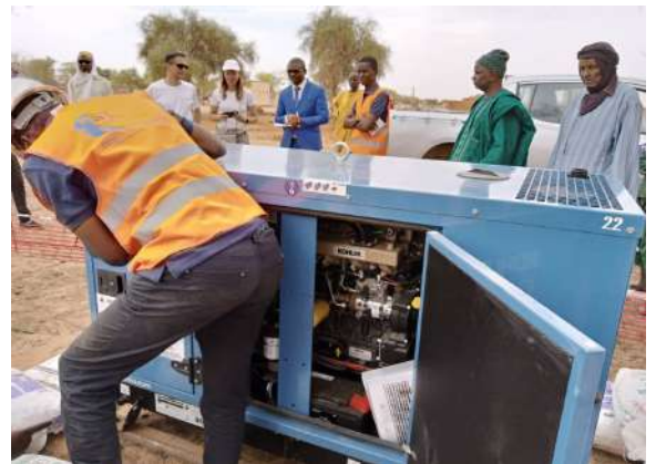
Installation de la plateforme solaire à Mbiddi
