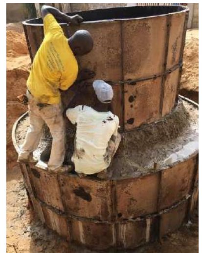
Installation d'un biodigesteur
