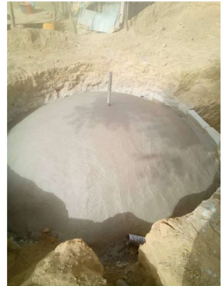
Construction d'une cuve de méthanisation permettant la production de biogaz
