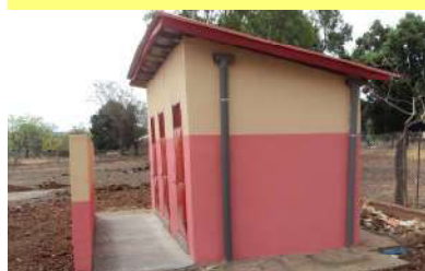
Bloc 3 cabines de Pourouya - 13/04/20
