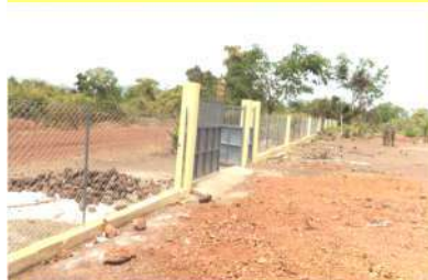
Clôture grillagée de Donghol Fafabhe - 15/05/20
