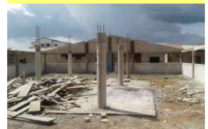
Visite du chantier du hangar du marché Radar - 18/06/20
