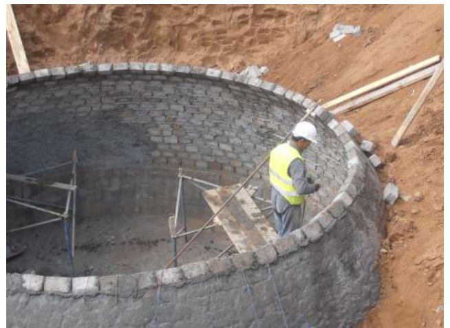
Construction de la cuve de biométhanisation de Laaounate
