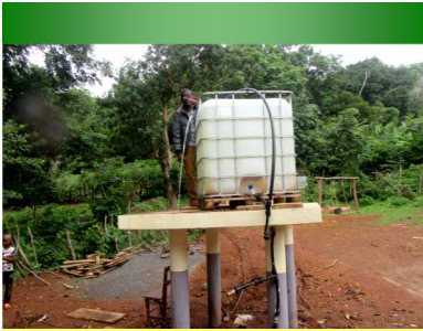
Château d'eau à l'école de Garantan - 07/08/19
