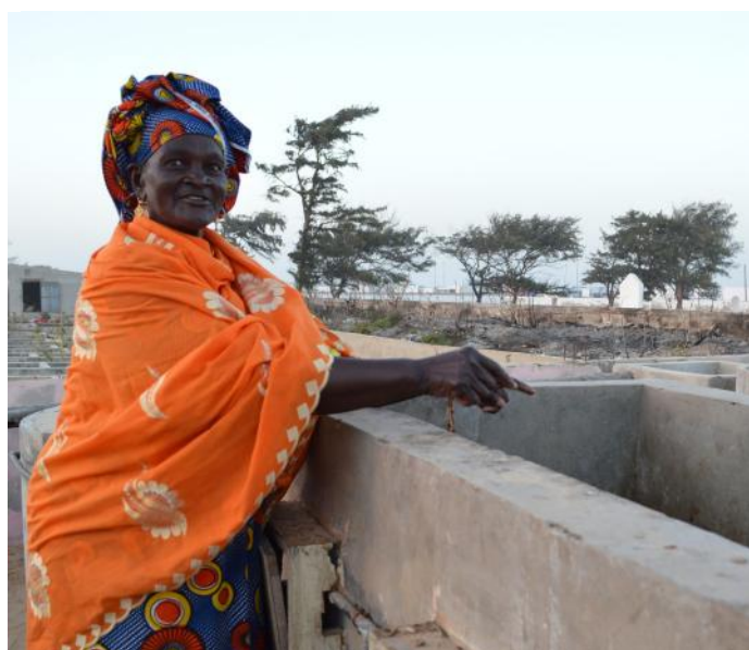
Les cuves de production de biogaz installées pour les femmes transformatrices de poisson de Guet Ndar
