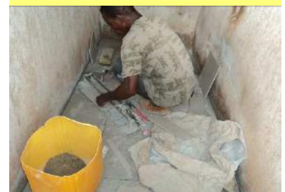
Pose du carrelage à Bowloko 2 - 13/09/18
