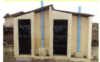
Latrines réhabilitées à Tata 1 - 30/09/18
