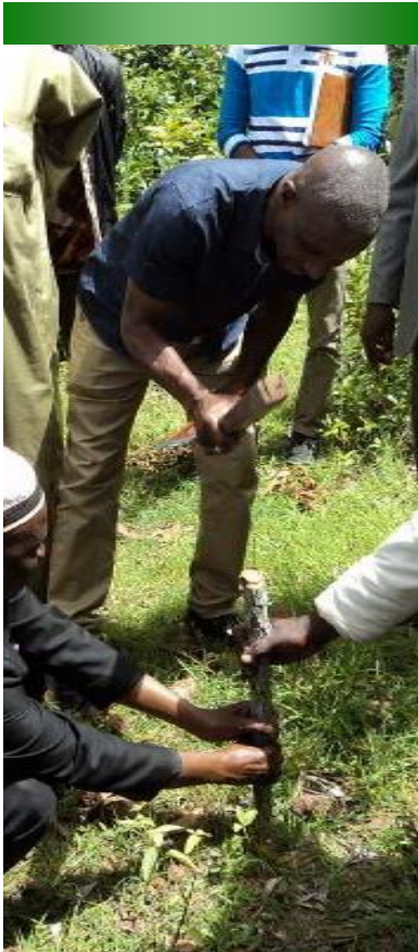
Mr DIALLO lors de l'implantation des travaux à Touri - 18/09/17
