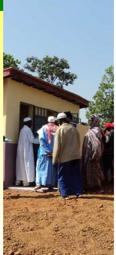
Réception provisoire des latrines à Touri – 10/11/17
