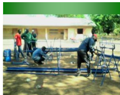
Montage des stations à Kalan - 18/04/19
