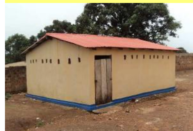
Le bloc de latrines de Bowloko 2 réhabilité - 28/05/19
